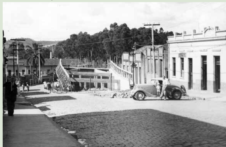
Construção do Viaduto da Ponte de São João, na Rua Dr. Torres Neves, sobre os trilhos da Estrada de Ferro Sorocabana e Companhia Paulista. Início da década de 1940
