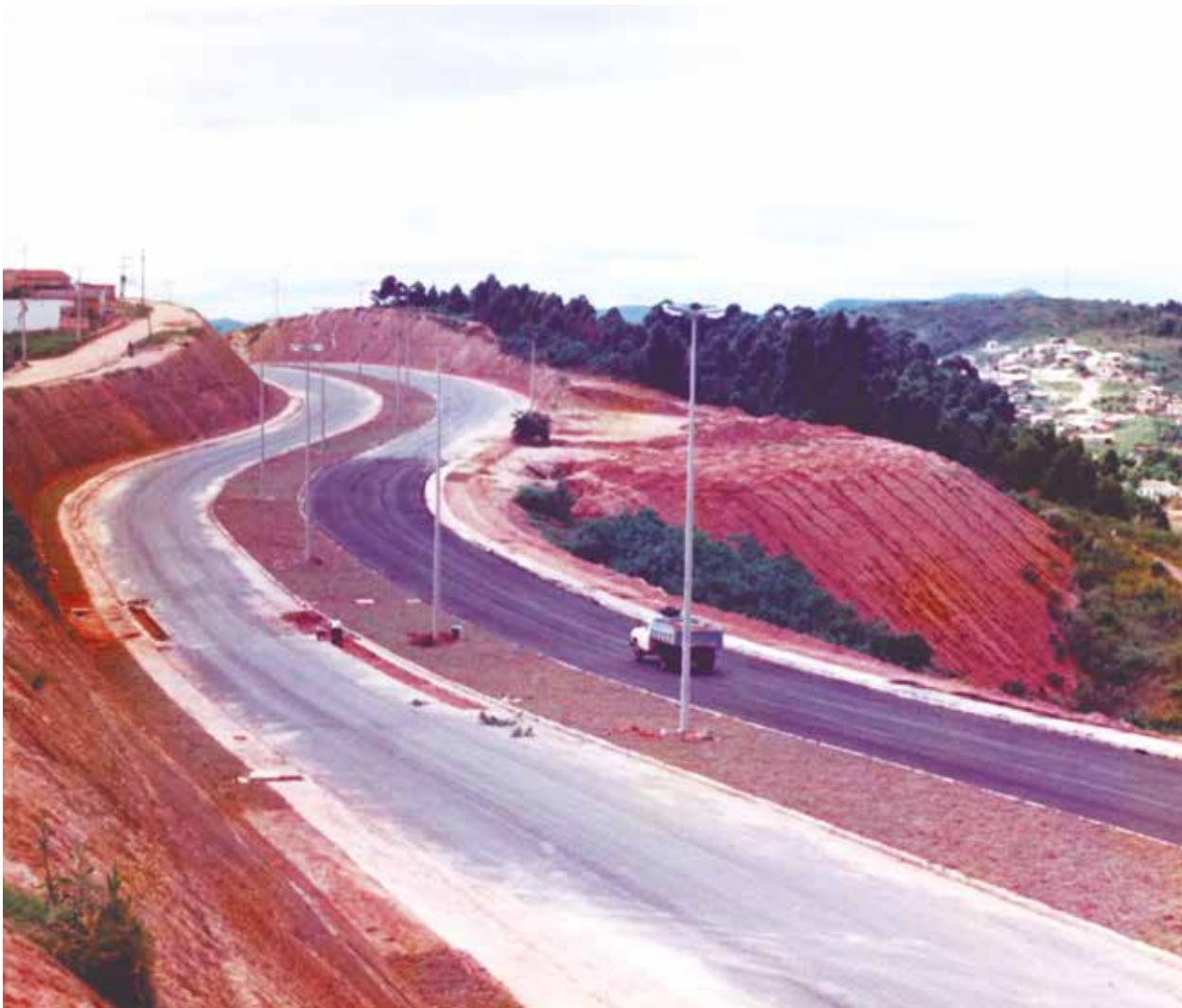
Construção da Avenida dos Imigrantes na região do Jardim Pacaembu/Vila Nambi
