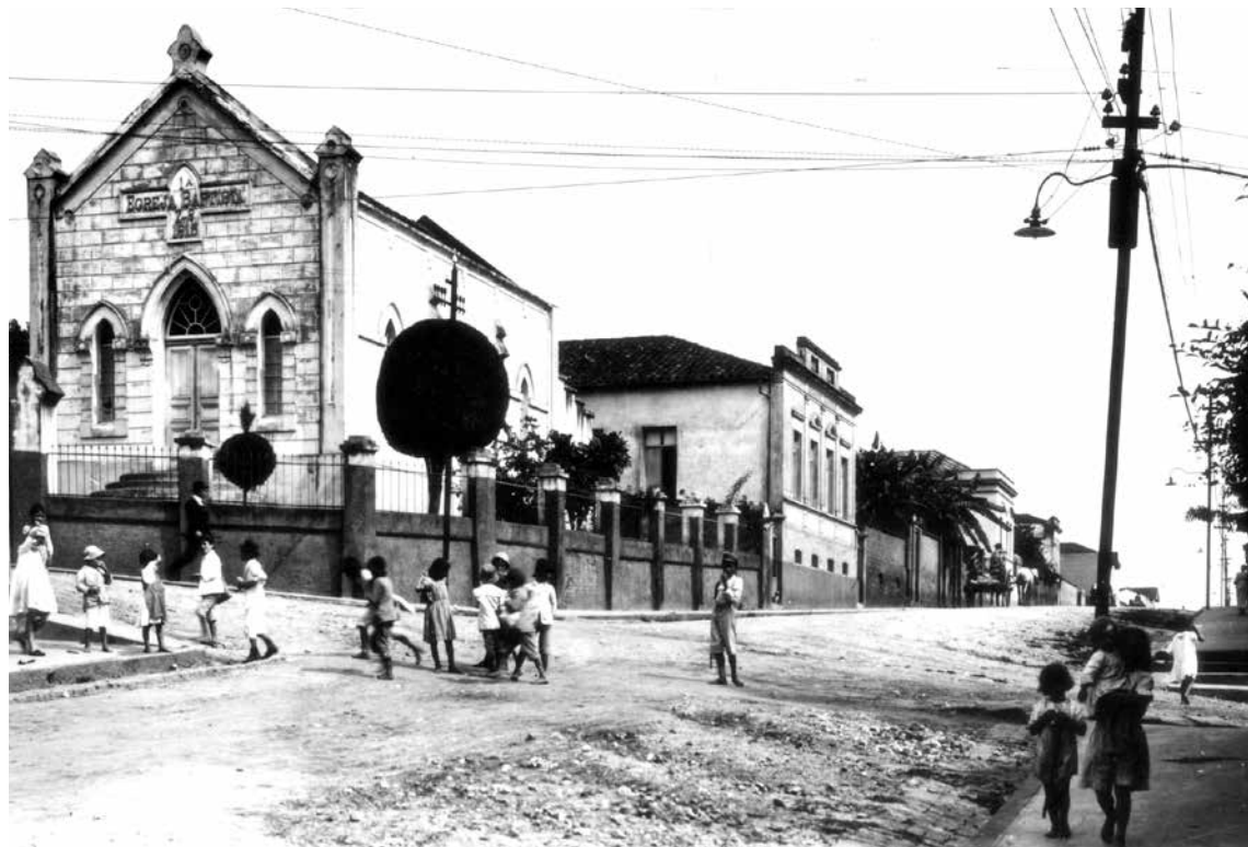
Rua Marechal Deodoro da Fonseca, esquina com a Rua Dr. Torres Neves, com destaque para a Primeira Igreja Batista
