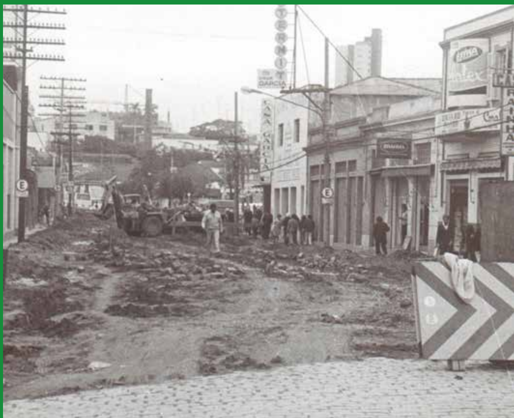
Obra na Rua Vigário J.J. Rodrigues, na Vila Arens, com a Casa Garcia ao fundo: rua ainda era de paralelepípedo
