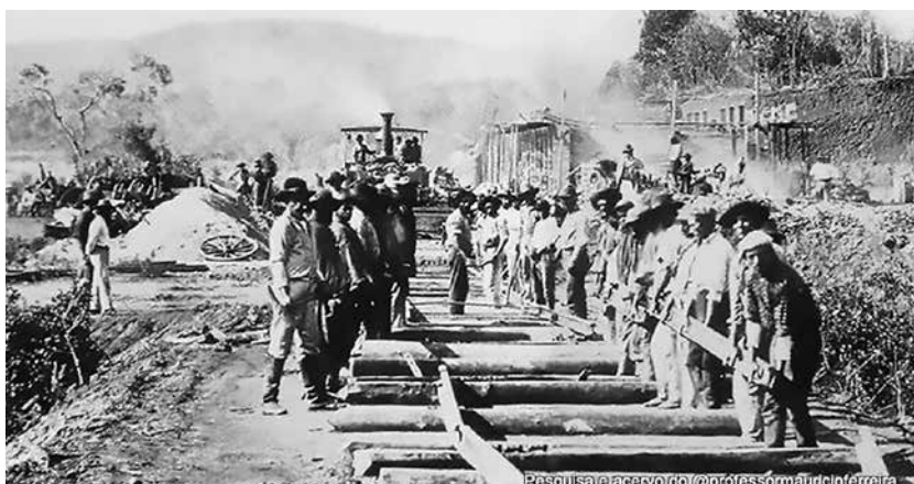
Construção da Ferrovia Santos a Jundiaí, obras no trecho de Jundiaí
